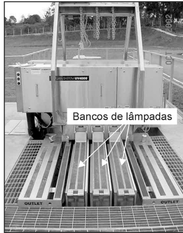
Figura 6.14 Processo UV com lâmpadas imersas e escoamento em canal.
