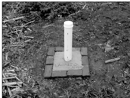
Figura 8.4 Detalhe do aspecto externo de um poço de coleta da água subterrânea.
